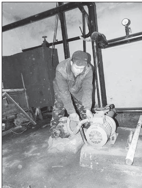
В котельной в Сосновке кипит работа
