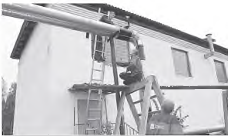
Тепловики Николай Елисеев, Виталий Гаврилов и Алексей Королёв впервые используют воздушную пенополиэтановую изоляцию на теплотрассе возле школы
