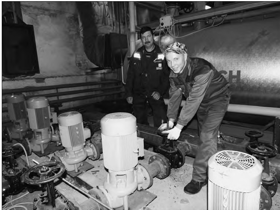
Работы в новой котельной подходят к завершению
