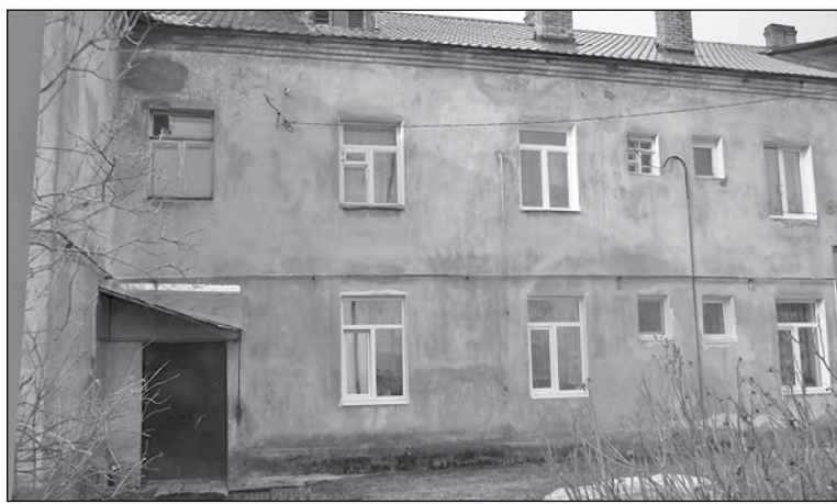
Собственники этого дома решили формировать фонд капитального ремонта на собственном счёте
