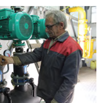
Новое оборудование котельных будет давать стабильное тепло
