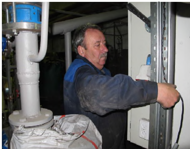
Лелетин Сергей Валентинович, электромонтер по ремонту и обслуживанию электрооборудования 5 разряда участка №10
