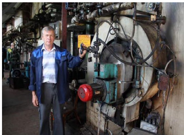
В.Г.Окунев - сменный мастер котельной №22 участка №4.
