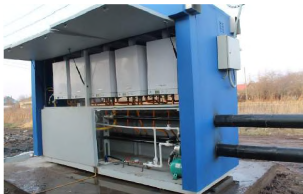
ТГУ заменит котельную №6
