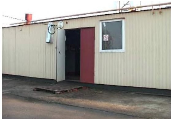
Блочнo-модульная котельная №3 в Дубовицах
