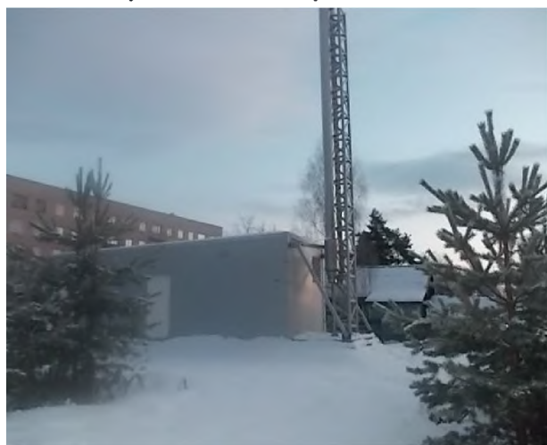
Новая БМК мощностью 1,2 МВт в п. Кулотино Окуловского района
