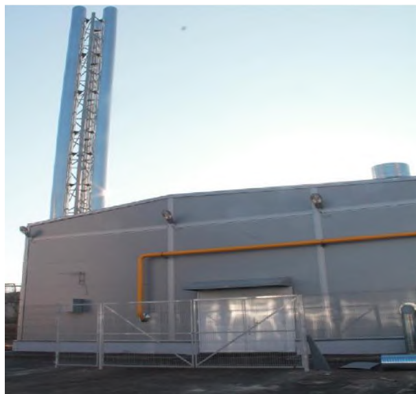
Новая БМК мощностью 21 МВт на пр. Васильева, 35 в г. Валдае
