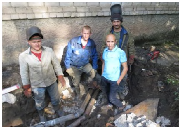
Ремонтная бригада участка №6 вместе с начальником участка Андреем Кольцовым прокладывают тепловую сеть для подключения новых ТГУ. На фото: электрогазосварщик О.Б. Гаврилов, водитель автомобиля Н.С. Петров, мастер А.В. Кольцов, электрогазосварщик Р.Д. Гацуун.
