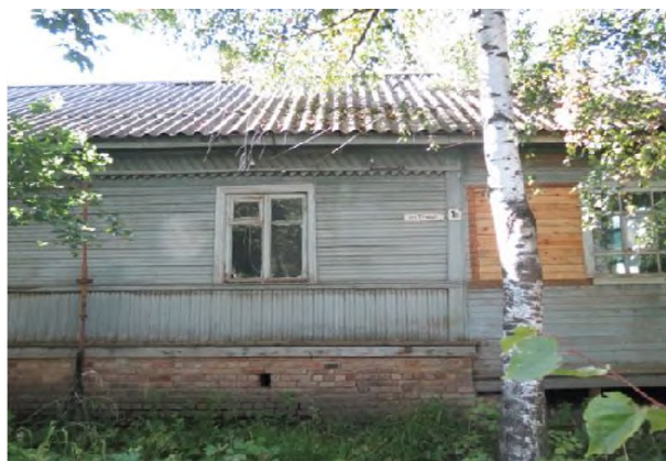
Благодаря ООО «ТКНовгородская» жители дома №1а на пл. Труда не останутся без тепла.
