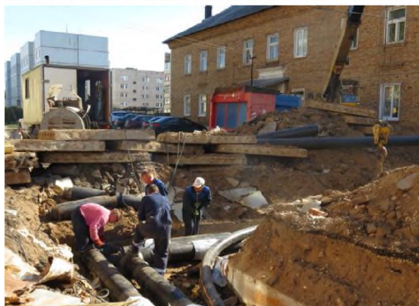
Работы по прокладке ИЗОЛЫ ведутся на улице Гоголя.
