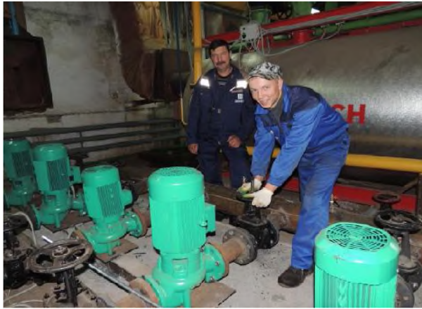
Работы в новой котельной подходят к завершению
