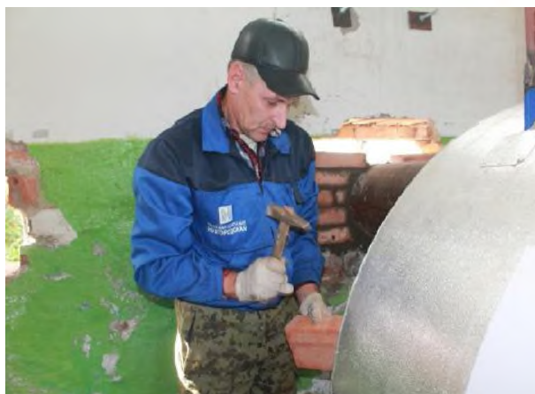
В котельной №10 недавно установлены новые котлы «Энтерос». Слесарь по ремонту оборудования котельных участка №2 А.А Захаров закладывает проем в стене при устройстве газохода.
