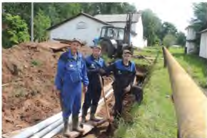
Новгородский район, деревня Новоселицы. Бригада рабочих ведет прокладку труб
