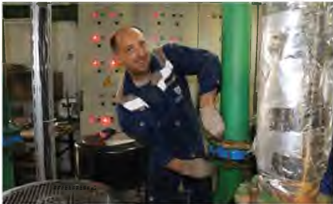
БМК 12,5 МВт п. Панковка. Мастер участка №1 А.А. Чуров проводит выборочный контроль соединяемых элементов
