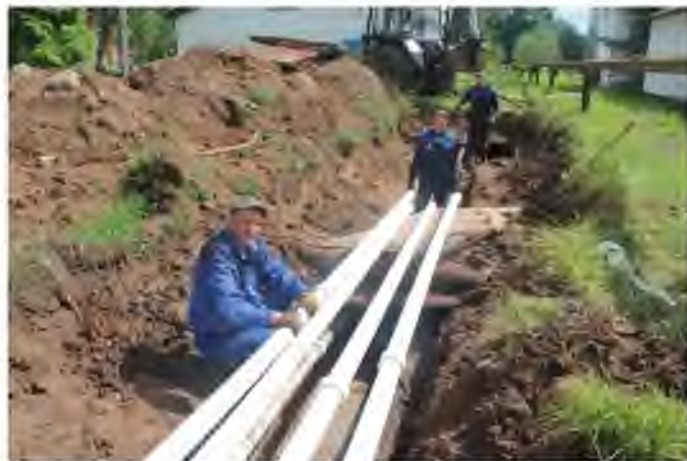
Новые трубы прослужат дольше
