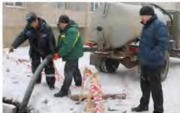
*Тепловики ликвидируют прорыв сети отопления на ул. Поперечная. После подготовительных работ трубу пропаяют под автомобильной дорогой*
