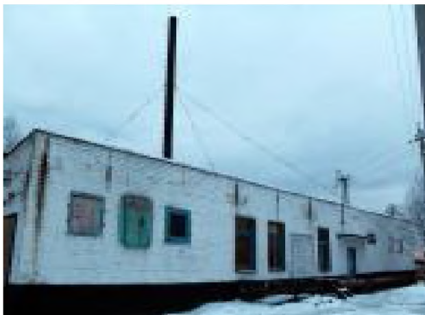
котельная №7- Батецкий район, д.Мойка
