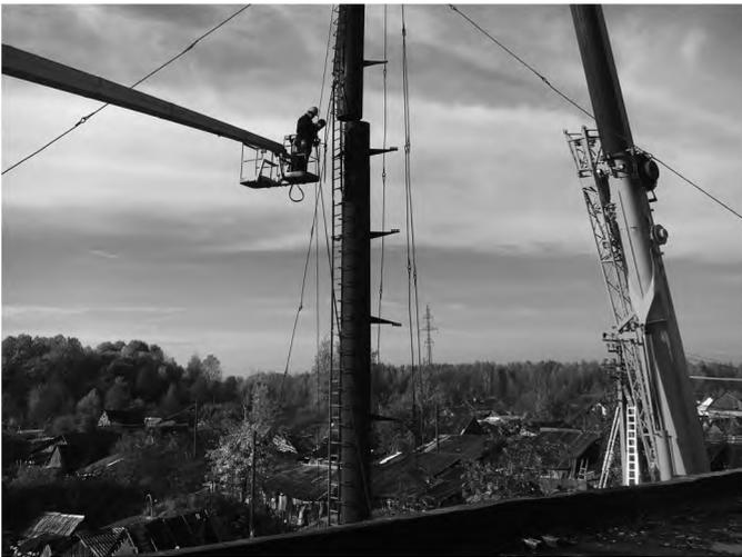
**В октябре в деревне Савино на котельной № 26 установили новый дымоход. Старый, аварийный, пришлось удалить по частям, дабы не повредить линии электропередачи и газопровод.**
