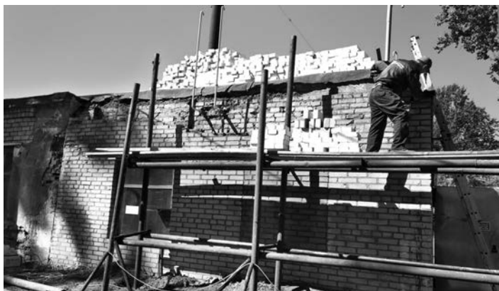
Капитальный ремонт кирпичной кладки стены котельной № 11
