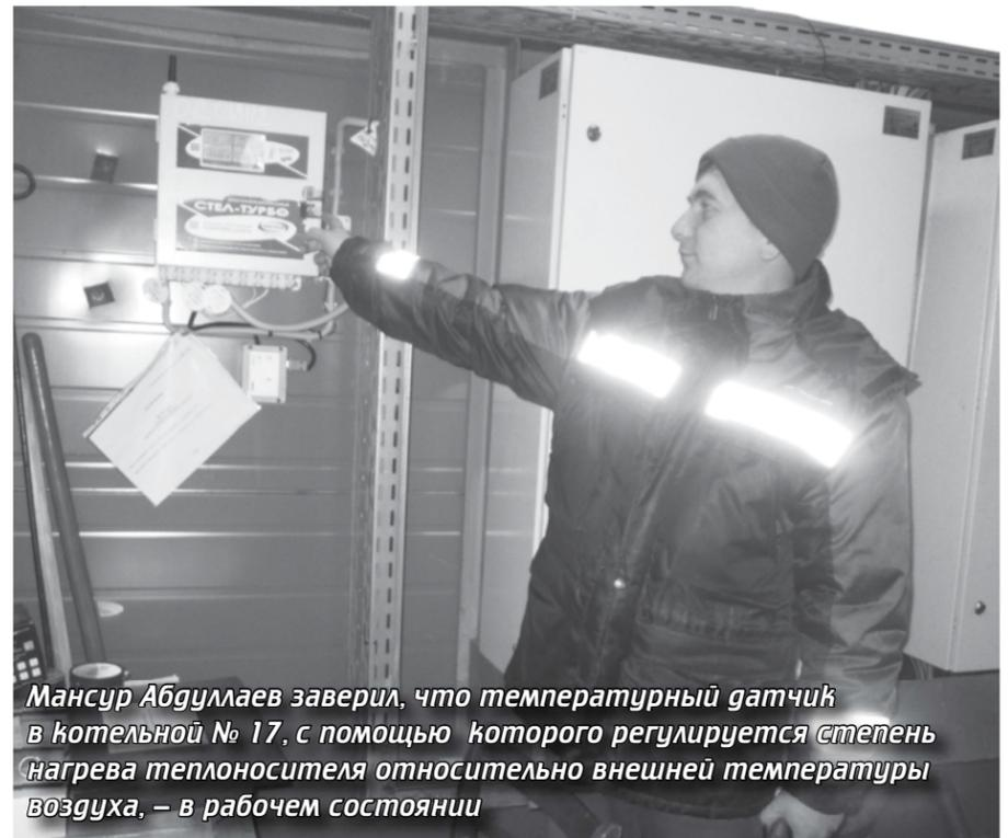
Мансур Абдуллаев заверил, что температурный датчик в котельной № 17, с помощью которого регулируется степень нагрева теплоносителя относительно внешней температуры воздуха, — в рабочем состоянии
