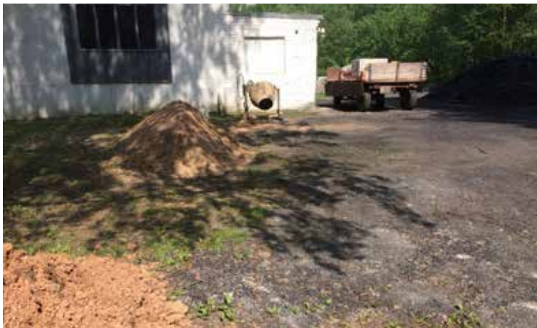
Начало июля. Подготовка к ремонту котельной у ЦРБ
