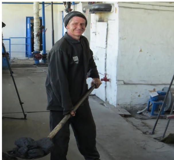
Валерий Ильин - машинист-кочегар котельной
