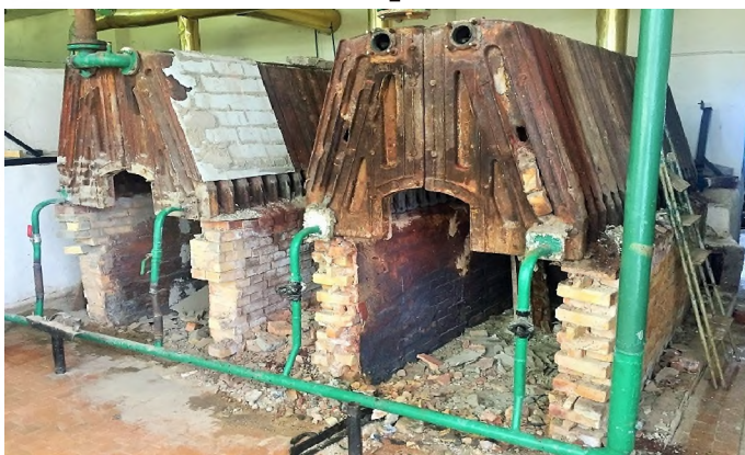
разборка обмуровки котлов
