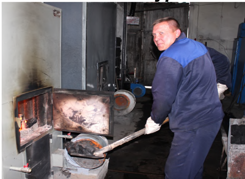
На фото: оператор котельной на ул.Луговой Сергей Алексеев
