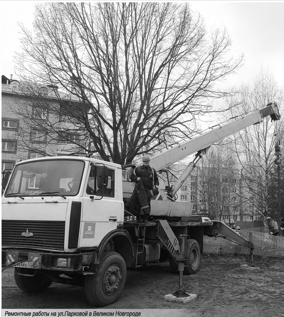
Ремонтные работы на ул.Парковой в Великом Новгороде
