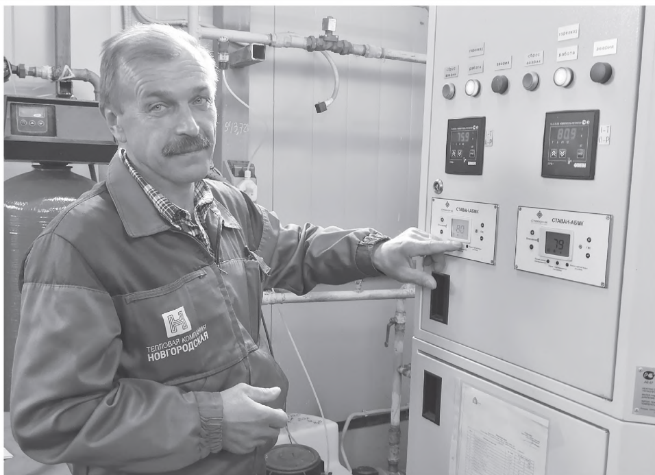
▲ Слесарь КИПиА Александр Степанов отключает газовую котельную в поселке Любытино
