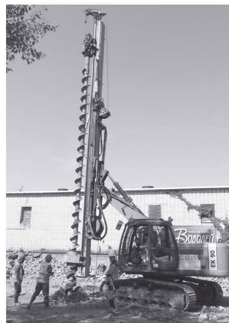
▲ Подготовка скважин для фундамента дымовой трубы в котельной №40 на ул. Зелинского
