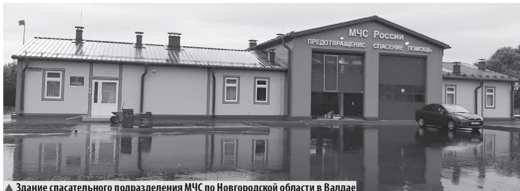
▲ Здание спасательного подразделения МЧС по Новгородской области в Валдае
