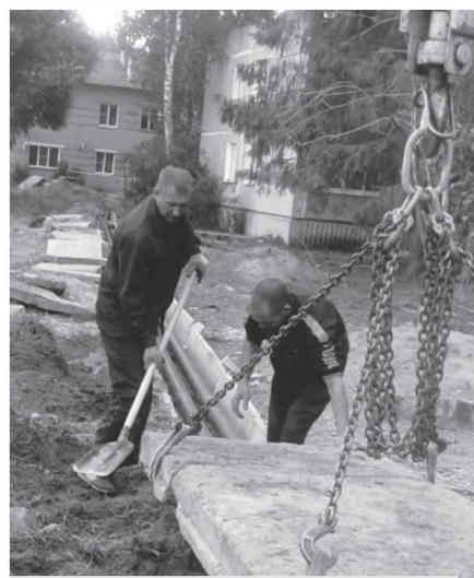
▲ Капитальный ремонт теплосетей в деревне Дуброво Солецкого района
