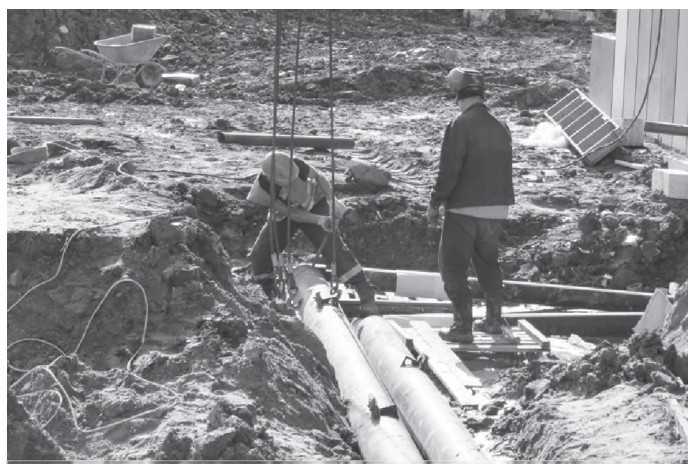
▲ Прокладка сетей к жилому дому на улице Вересова в Великом Новгороде
