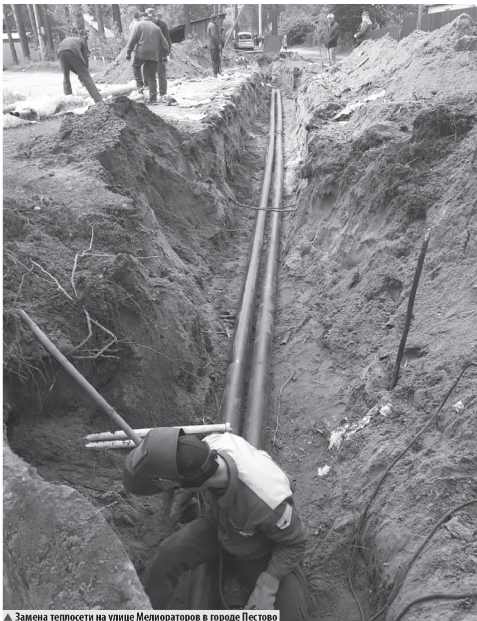
▲ Замена теплосети на улице Мелиораторов в городе Пестово
