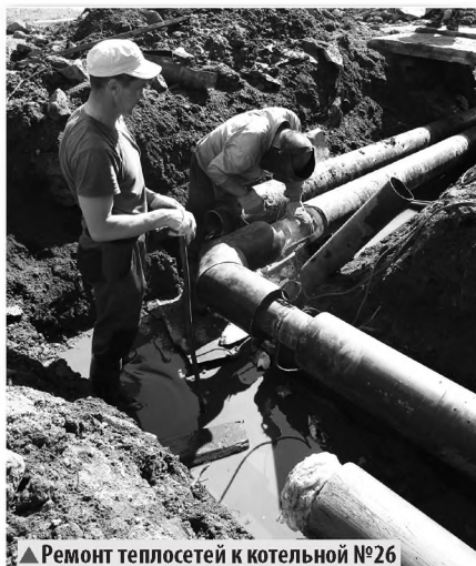
▲ Ремонт теплосетей к котельной №26
