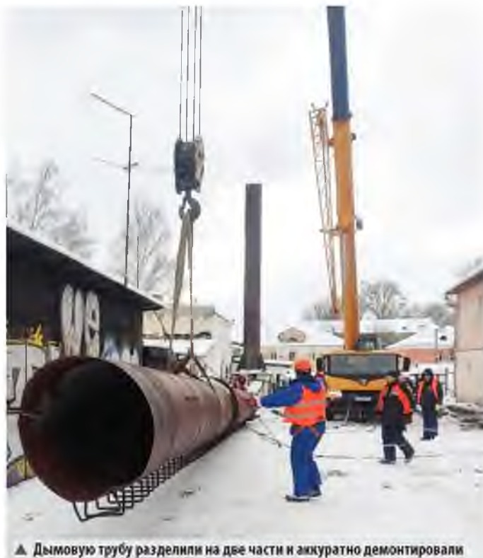
▲ Дымовую трубу разделили на две части и аккуратно демонтировали
