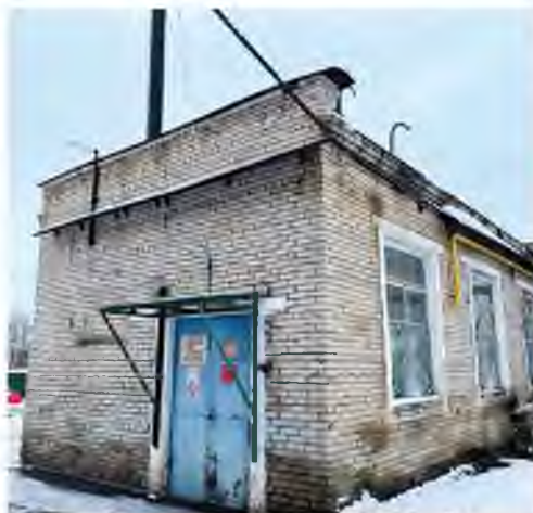
▲ После техперевооружения котельная в Панковке будет работать в автоматическом режиме
