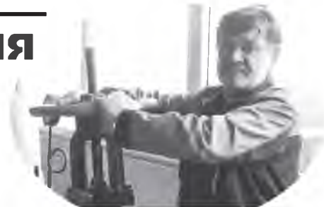
▲ Оператор котельной перекрыв подачу газа к водогрейным котлам
