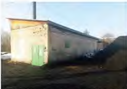
▲ Взамен угольных котельных появятся современные газовые
