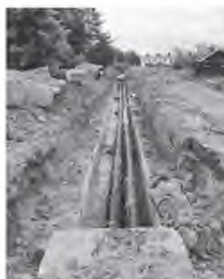
▲ В Чудове тепло пойдёт по новым трубам к жилым домам и социальным объектам
